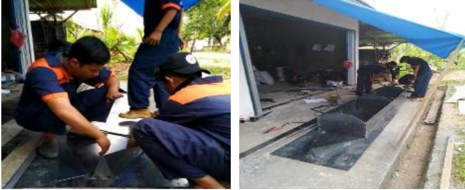
Gambar 4. Proses Penyambungan Pelat
